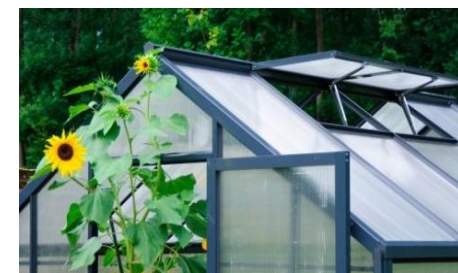
Способ 2. Проветривание с помощью форточек и открытой двери
